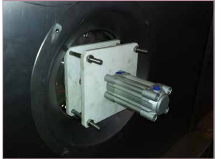
Taze hava giriş klape sistemi Fresh air inlet flap system
